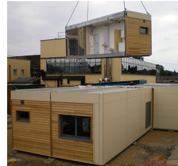
(b) Ein Gebäude, dessen Stabilität durch die Wände der Module entsteht (Triumph Modular, o.D.).
